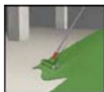
műgyanta felhordása hengerrel 2 rétegben
